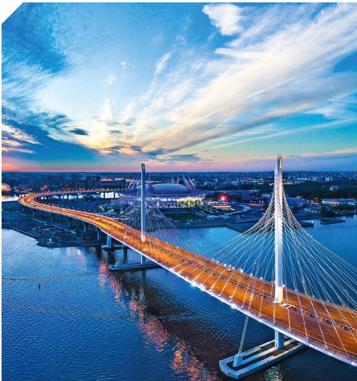
Мост через Петровский фарватер, Санкт-Петербург
